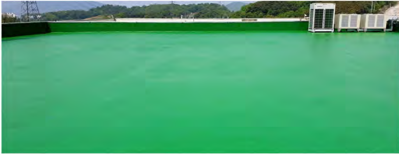
우레탄 방수 우레탄 도막 방수 공법 친환경도막방수 AL-30 / AL-50 도막 방수 공법
