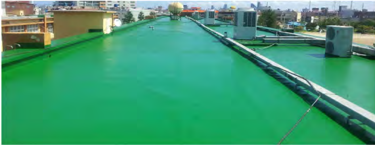
밀착공법 TL-30 복합 시트 방수 공법 절연공법 TL-50 복합 시트 방수 공법
