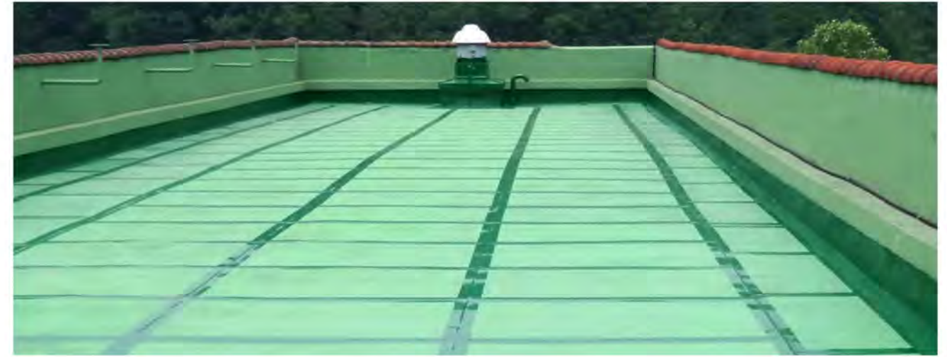
아스팔트 방수 아스팔트 시트 방수 공법 (밀착공법) PET 시트 방수 ML-30 시트 방수 공법 (절연공법)
